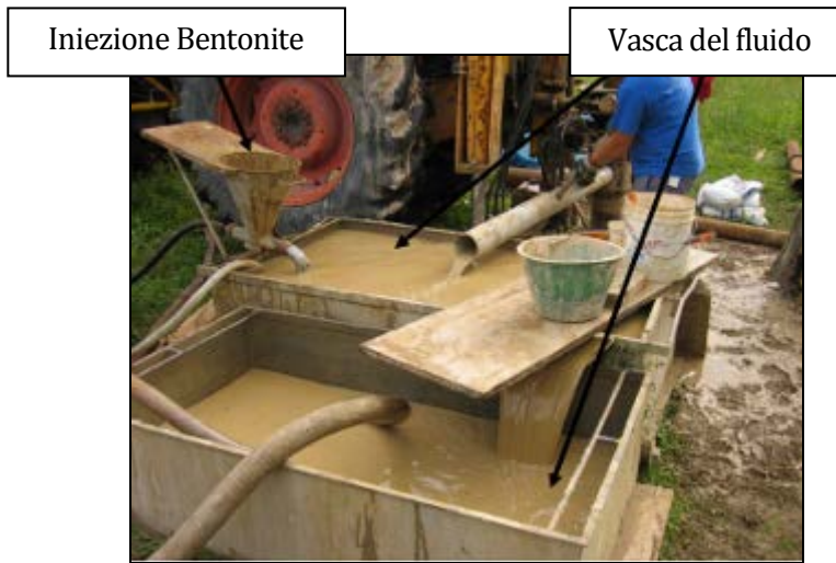
Fig. 8 - Vasche del fluido bentonitico
