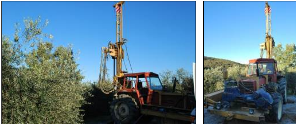
Fig. 2 - Impianto di perforazione tipo per sondaggi superficiali con pompa
